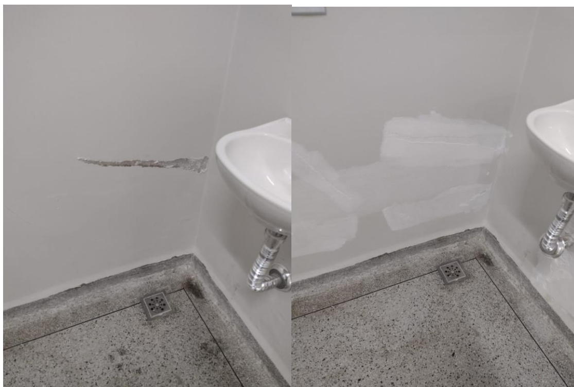
Reparo na pintura dos consultórios.
