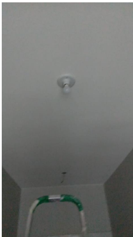
Instalação de luminárias tipo Paflon.
