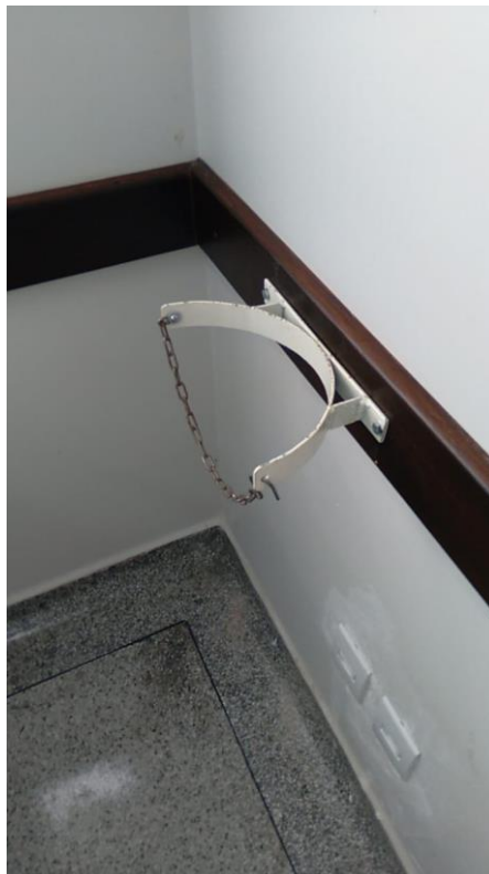
Fixação do suporte dos cilindros.
