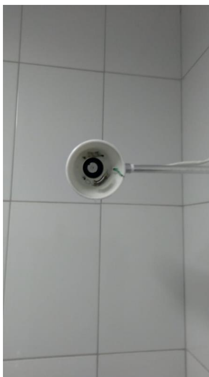
Troca de Resistência do Chuveiro.
