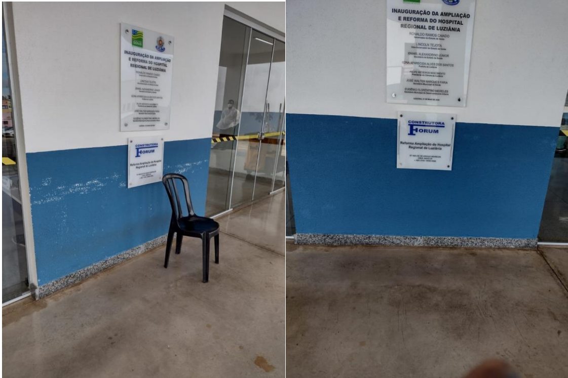
Revitalização da pintura em azul.
