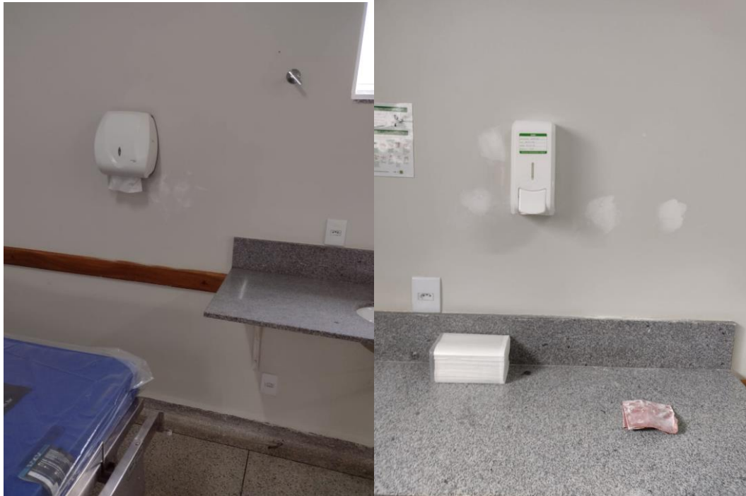
Instalação de novos dispensers.
