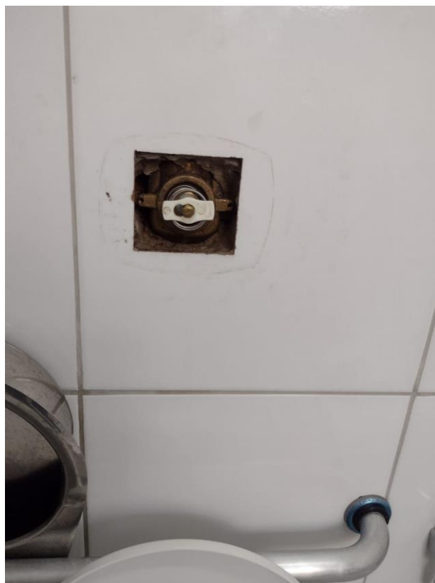
Reparo nas válvulas de descarga.
