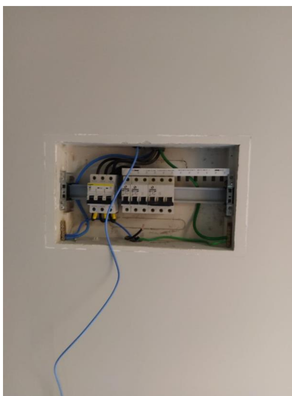
Instalação do Circuito do Foco Cirúrgico.
