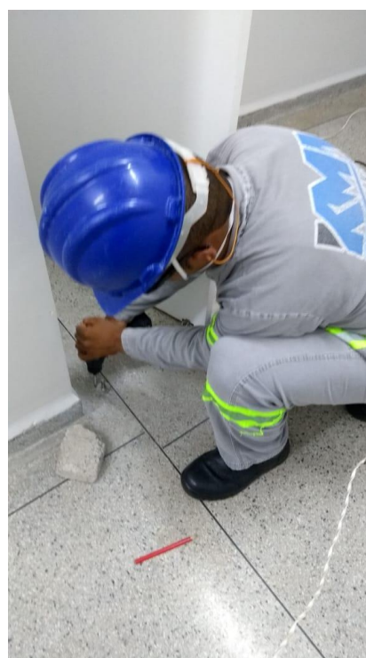
Instalação das travas fixas das portas.
