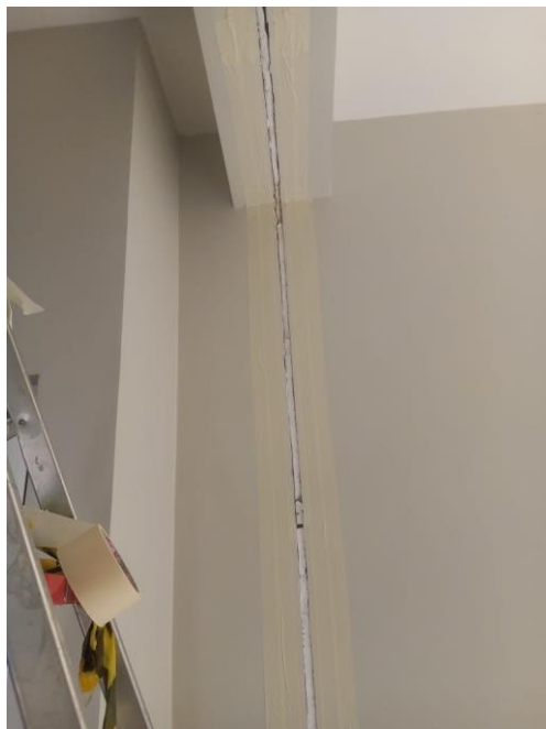
Tratamento da junta de dilatação.
