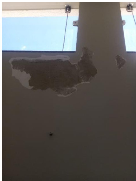
Tratamento dos pontos de Infiltração.
