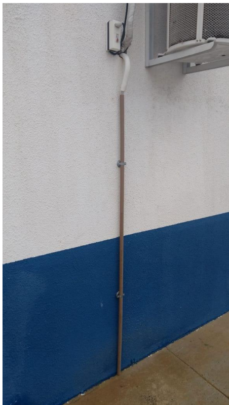
Instalação do drena do ar condicionado.
