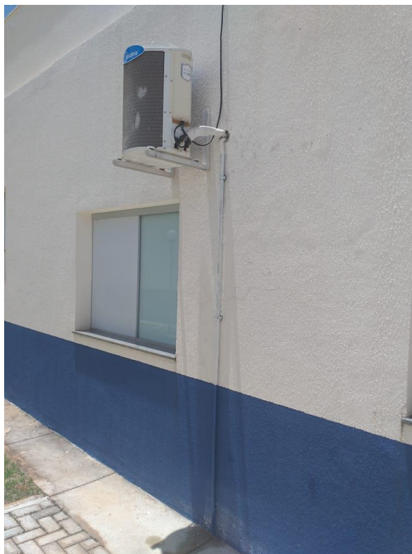
Instalação do drena do ar condicionado.
