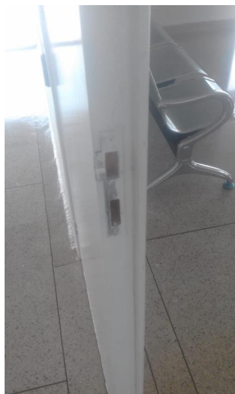
Fixação do batente da porta na recepção do PS.
