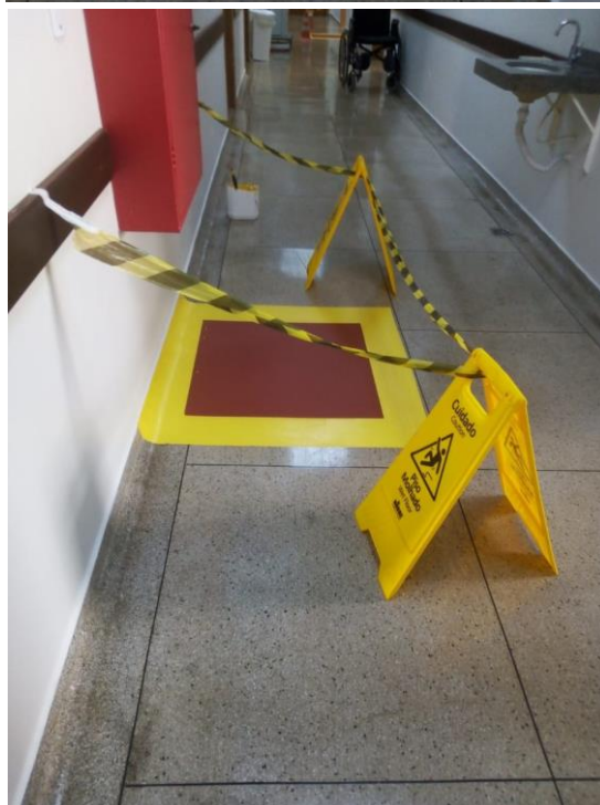
Pintura da Sinalização Visual dos Hidrantes.
