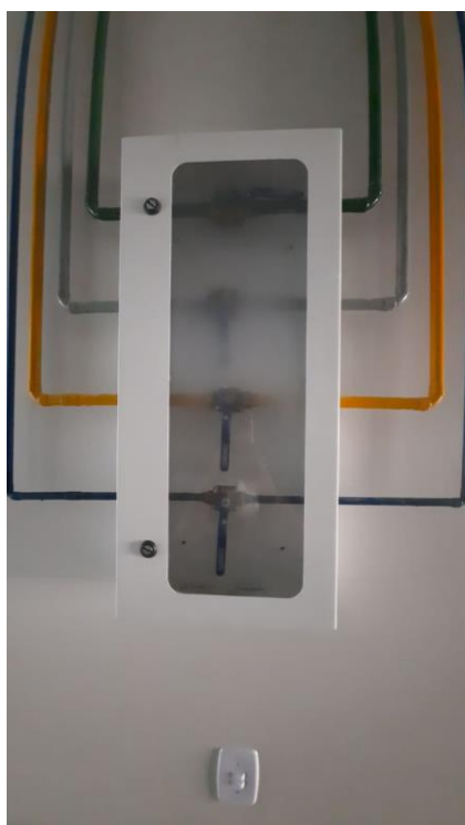
Troca do visor de acrílico da caixa de seção dos gases.
