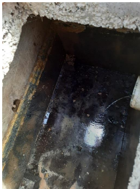
Limpeza e Sucção da fossa/caixa de gordura.
