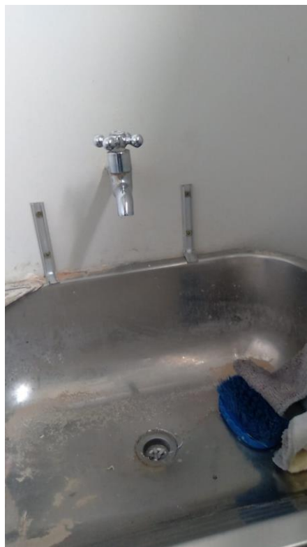
Reforço da fixação da pia de inox no DML.
